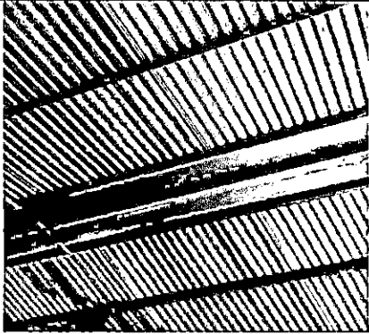
Foto 1: Cubierta de lámina.
